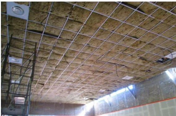
Faux plafond acoustique et isolation avec laine de roche
