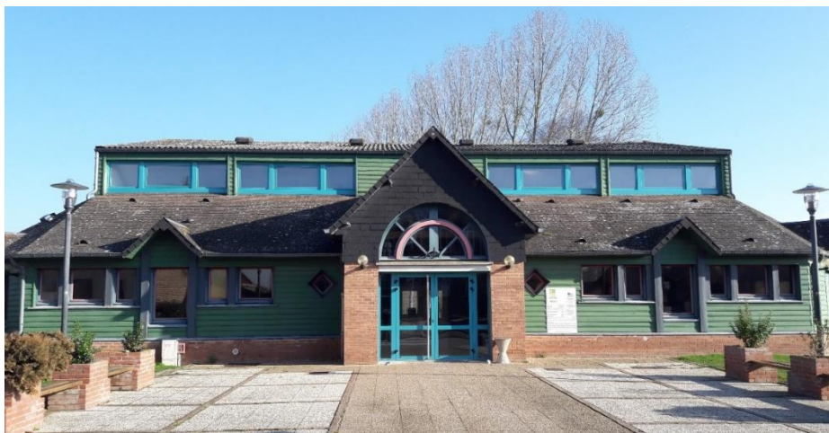
Menuiseries extérieures en aluminium à rupture de pont thermique
