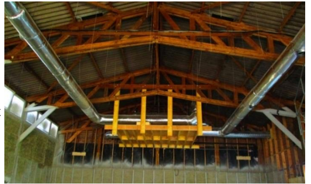
Faux plafond acoustique et isolation avec laine de roche
